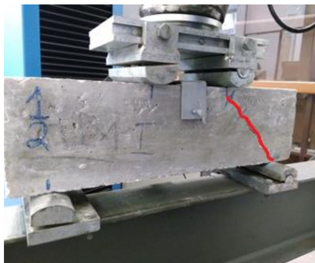
Figura 17 – V01-B fissuras após o ensaio
