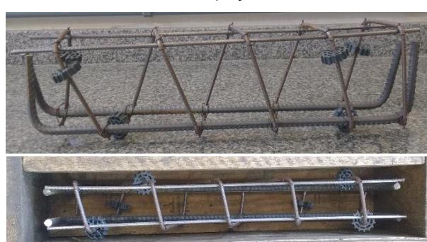
Figura 12 – Armadura V06 com estribos contínuos com Ø 5,0 mm e espaçamento de 10,0 cm.
