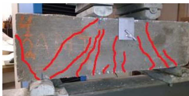
Figura 29 – V04-B fissuras após o ensaio.
