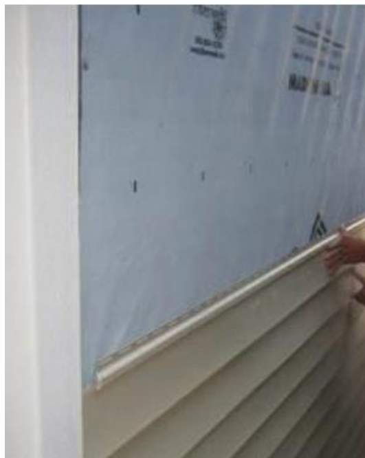
Figura 25 - Esquema de montagem do Siding Vinílico
