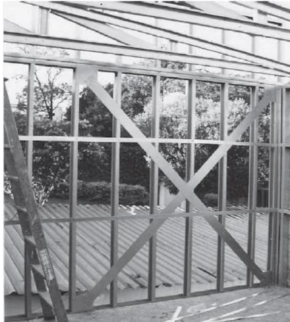
Figura 13 – Tipo de painel com contravetamento em “X”.
