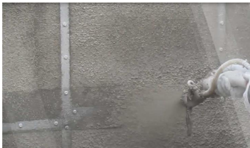
Figura 28 - CRUPE SYSTEM Projeção de Argamassa sobre Estrutura em LSF.
