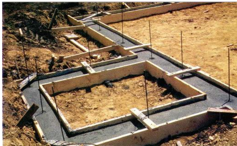
Figura 6 - Fundação em Sapata Corrida.
