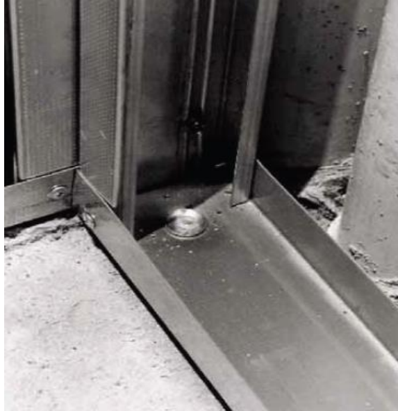
Figura 10 – Uso de parabolts na ancoragem
