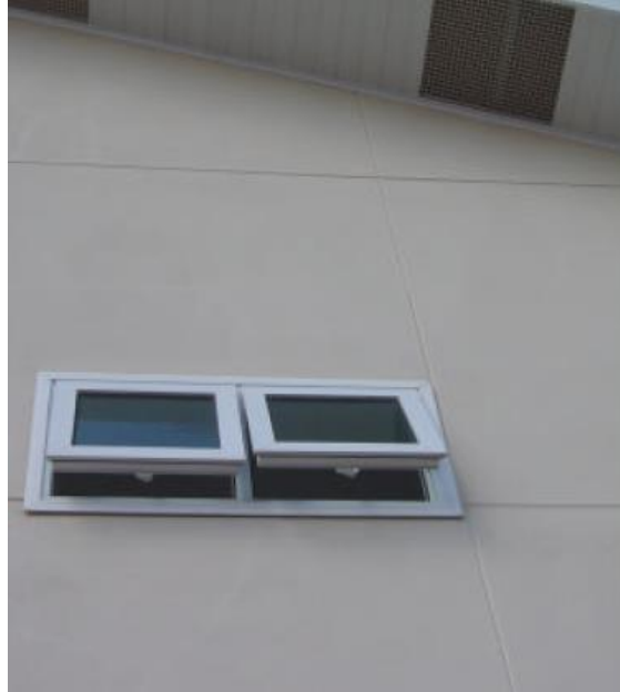
Figura 27 - Fachada revestida com argamassa com juntas aparentes.
