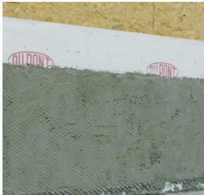
Figura 26 - Revestimento das placas de OSB com argamassa.
