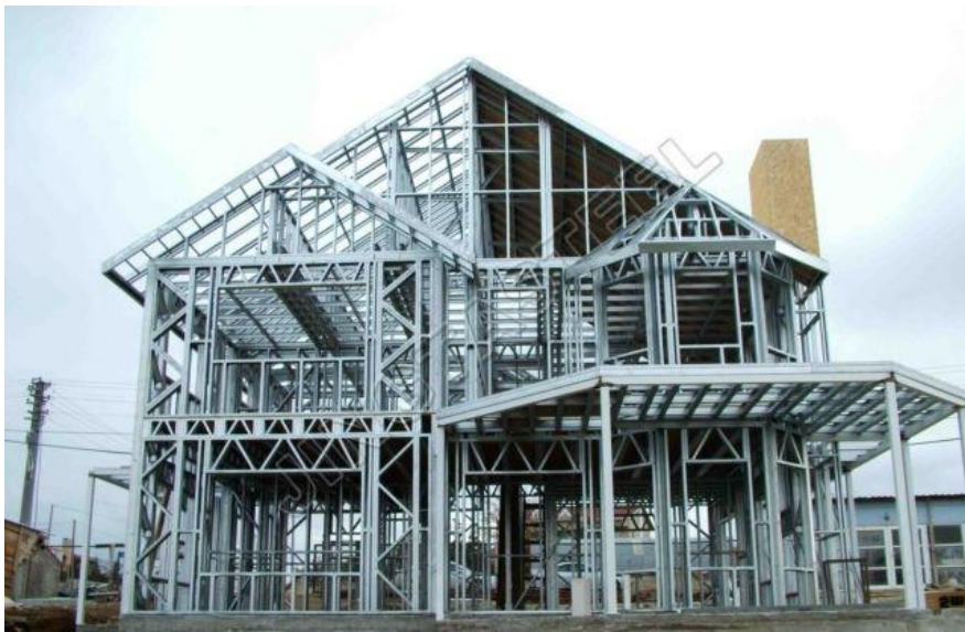
Figura 2- Estrutura de residência em Light Steel Frame
