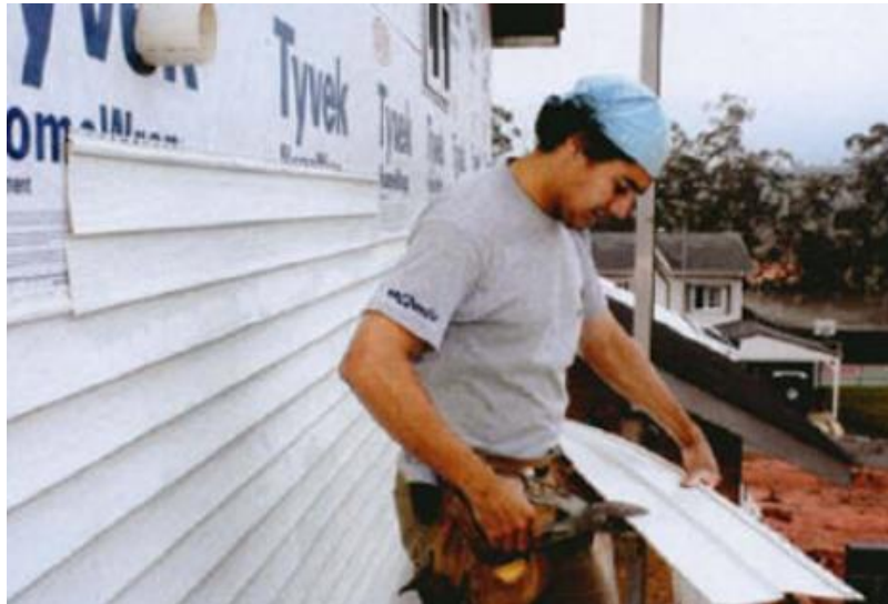
Figura 24 - Instalação de Siding Vinílico nas paredes externas do LSF.
