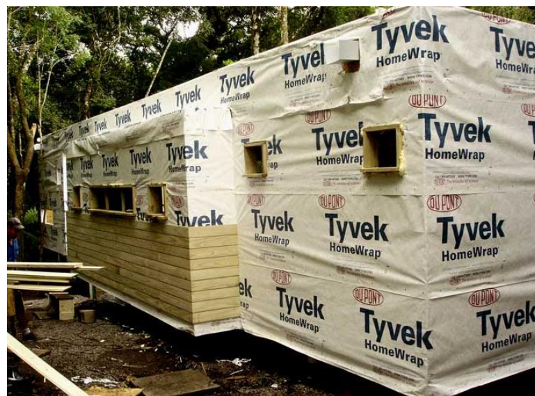
Figura 23 - Impermeabilização das placas de OSB com membrana TYVEK.
