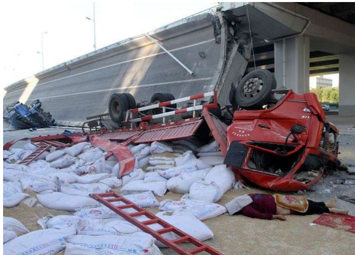
Figura 8: Acidente na China devido à carga excessiva na ponte (REUTERS/China Daily, 2012)
