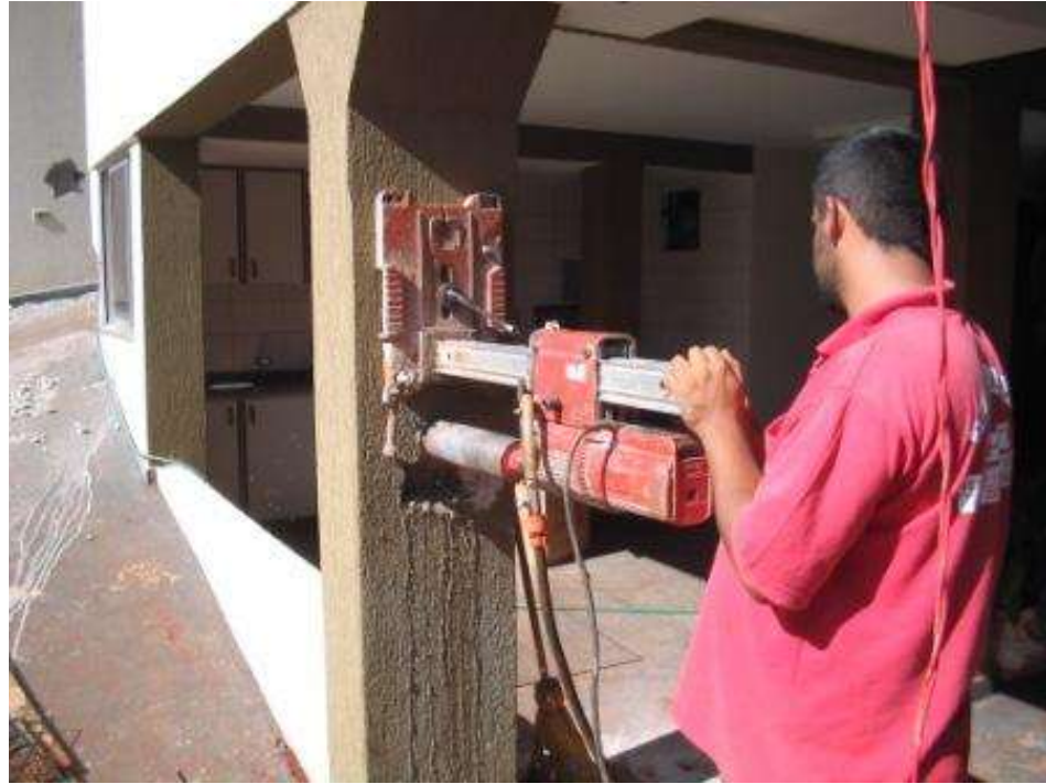
Figura 41: Retirada de testemunho (RODRIGUES, 2012)
