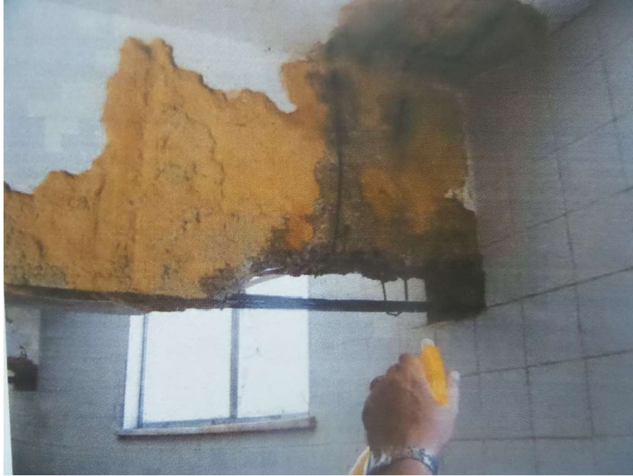
Figura 26: Superfície carbonatada na Biblioteca Benedito Leite em São Luís/MA (AGUIAR, 2010)
