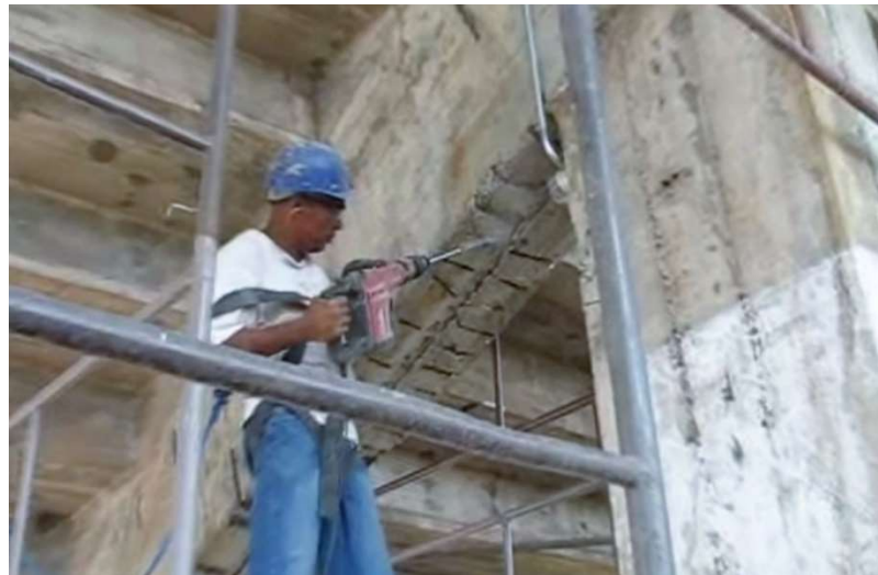
Figura 71: Preparação da superfície do concreto do Estádio Fonte Luminosa em Araraquara/SP (ATHENA ENGENHARIA, 2009)
