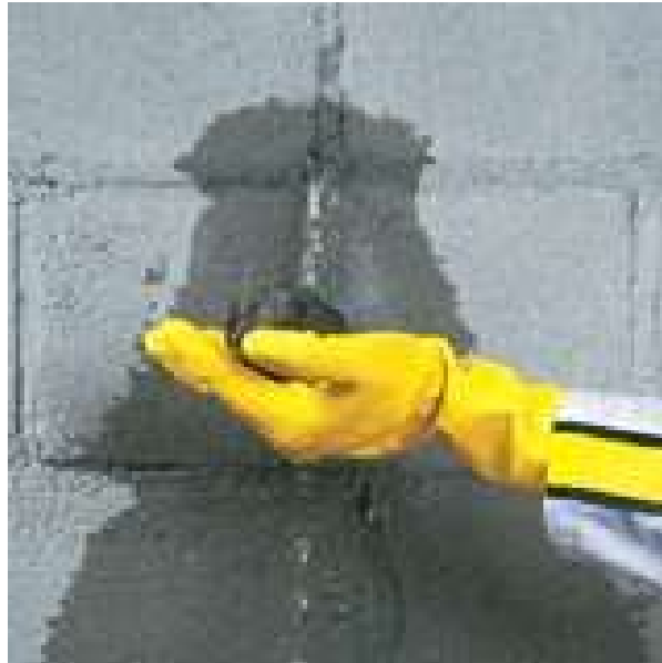
Figura 61: Aplicação da argamassa (WEBER SAINT-GOBAIN, 2014)
