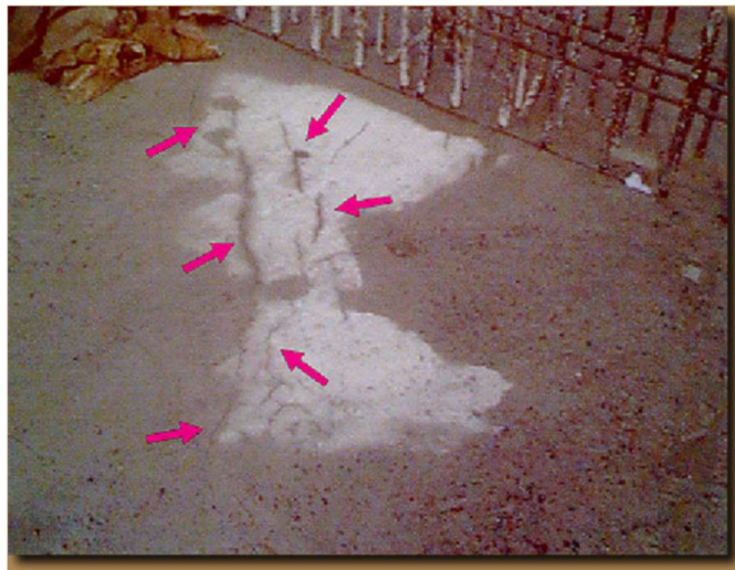
Figura 9: Retração no concreto plástico
