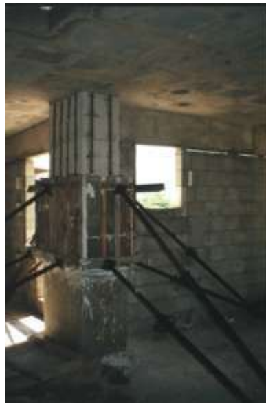
Figura 65: Fôrma escorada em reforço com concreto (FORTI, 2000)
