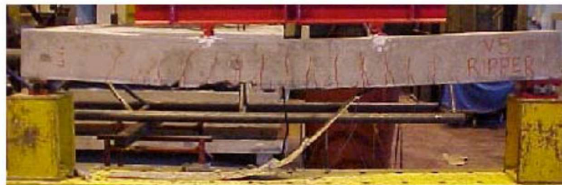
Figura 19: Fissuras de flexão em uma viga ensaiada em laboratório. Fonte: RIPPER, 1999
