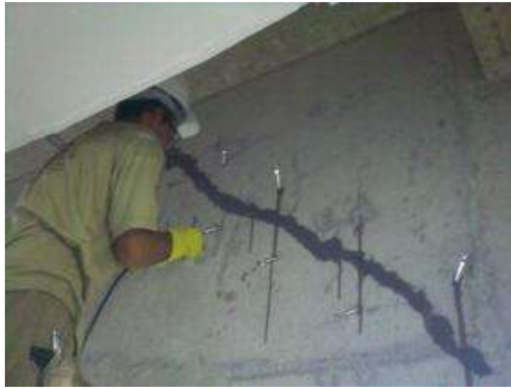
Figura 55: Selagem de fissura (ALZATA ENGENARIA, 2014)
