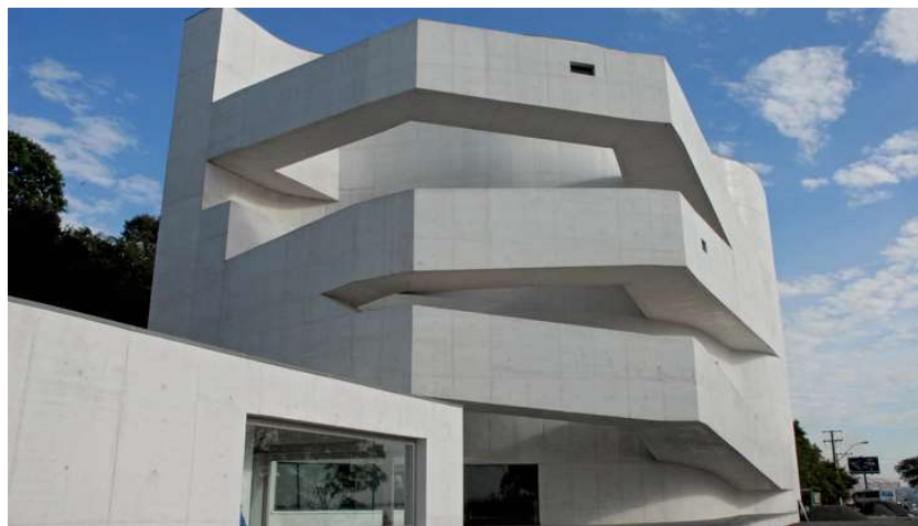
Figura 35: Estrutura com proteção superficial do concreto aplicado (MILAN, 2014)
