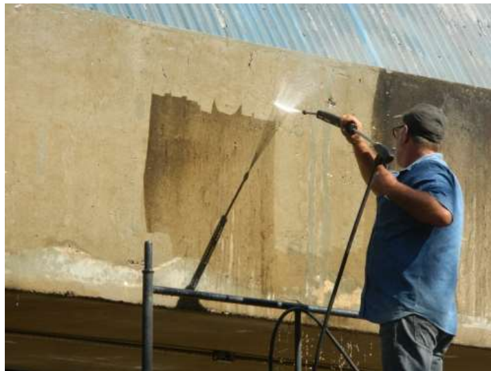
Figura 33: Limpeza da estrutura de concreto da rodoviária de Araras/SP
