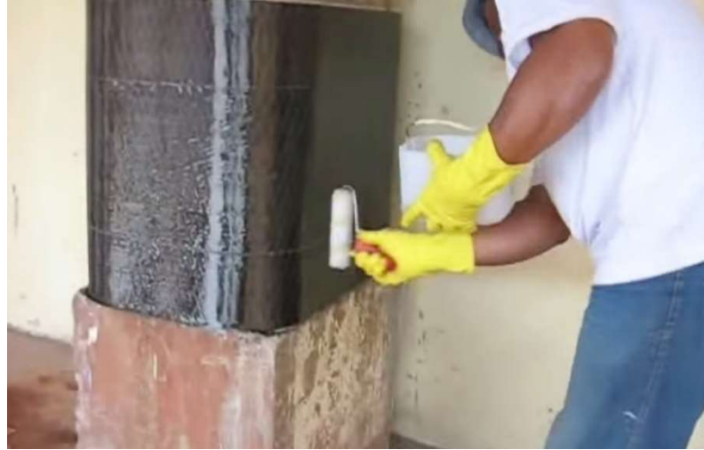
Figura 75: Aplicação da camada final de resina de recobrimento das fibras (ATHENA ENGENHARIA, 2009)
