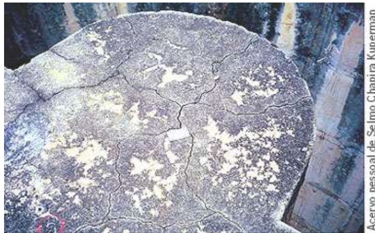
Figura 13: Reação álcali-agregado
