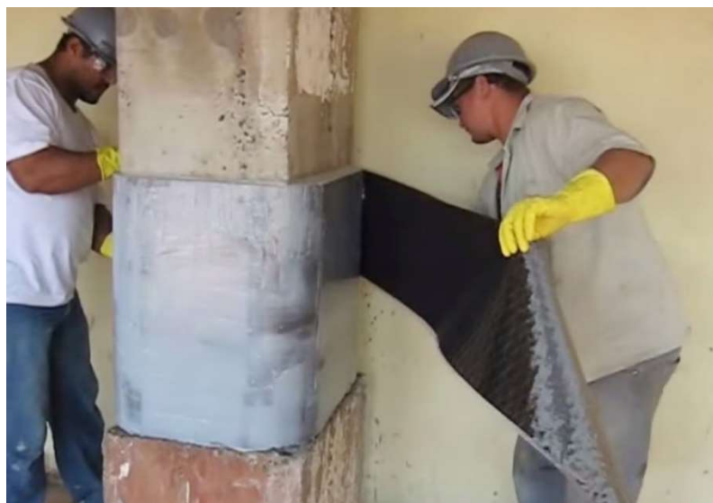
Figura 74: Aplicação da fibra de carbono (ATHENA ENGENHARIA, 2009)
