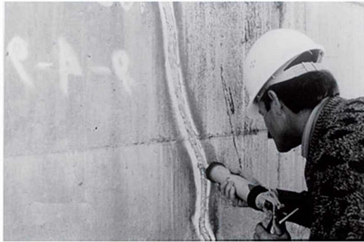
Figura 56: Injeção de fissura (RIPPER, 1998)
