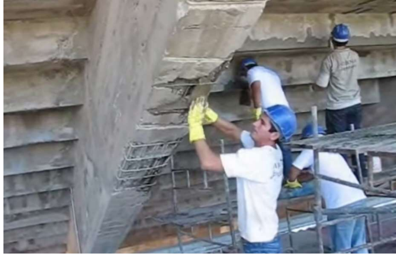
Figura 72: Aplicação de argamassa epoxídica (ATHENA ENGENHARIA, 2009)
