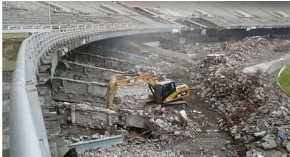
Figura 54: Demolição parcial da estrutura do Maracanã (FIFA, 2011)
