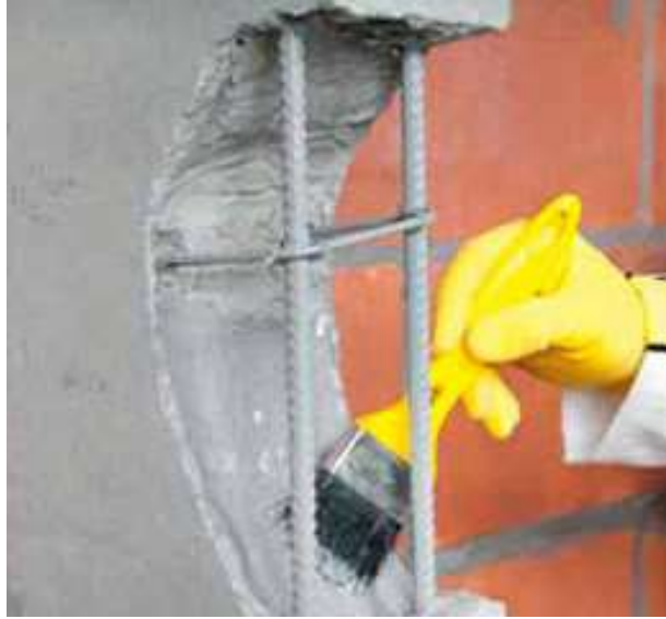
Figura 60: Aplicação da ponte de aderência (WEBER SAINT-GOBAIN, 2014)
