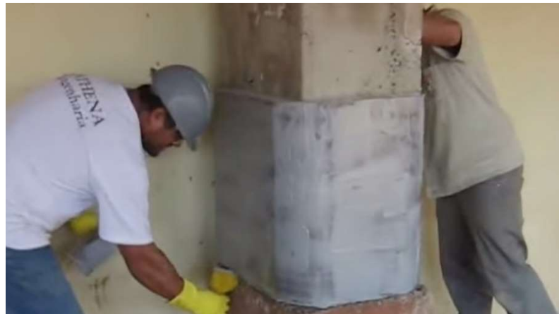
Figura 73: Aplicação do primer (ATHENA ENGENHARIA, 2009)
