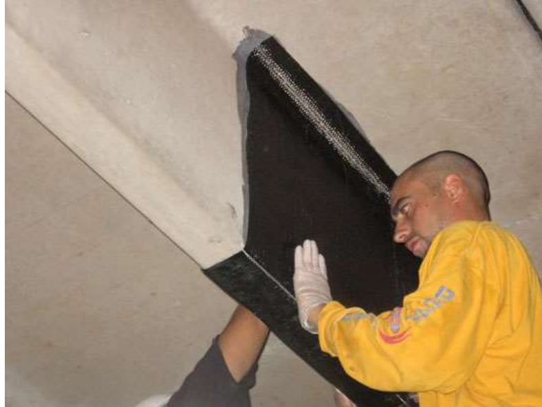
Figura 69: Reforço por chumbamento de perfis metálicos (SOUZA, 2011)
