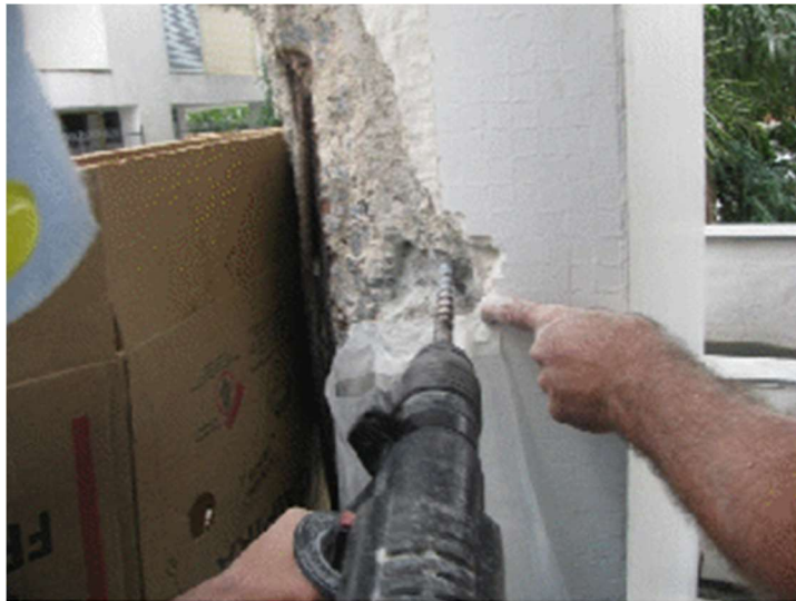
Figura 43: Preparação da superfície (TOMAZELI, 2013)
