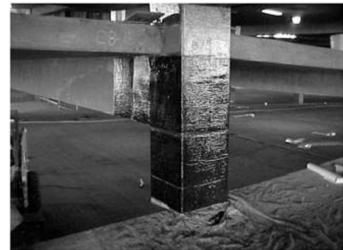
Fotografia 9.8 – À esquerda, reforço de colunas de concreto por confinamento. À direita, reforço de pilar de seção retangular, também por confinamento.
