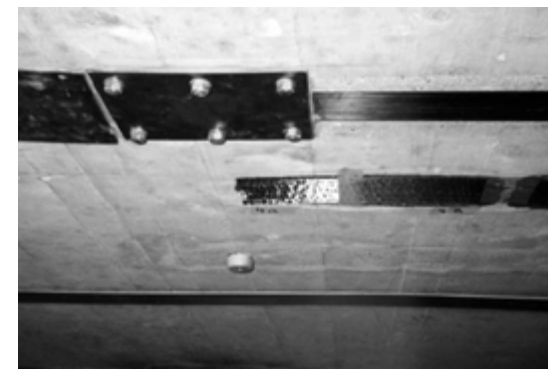
Fotografia 6.2- Ancoragem complementar de laminado.
