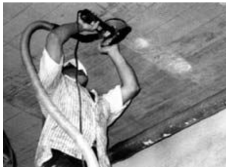
Fotografia 3.1 – Limpeza de superfície com politriz elétrica.
