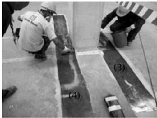
Fotografia 3.7 – Fases construtivas (3) e (4).
