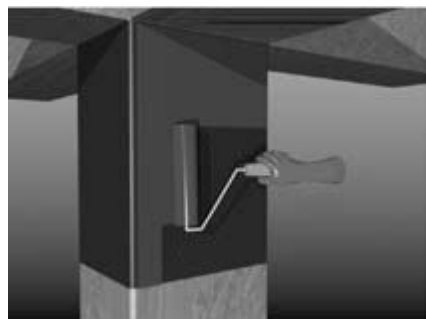
Figura 3.11 – Aplicação do revestimento protetor.
