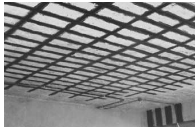
Fotografia 9.1 – Reforço de fibra de carbono para transformar laje de cobertura em laje de piso.
