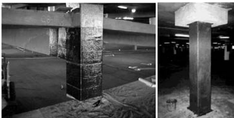
Fotografia 2.3 – Reforço de pilares por confinamento.
