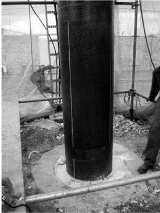
Fotografia 9.13 – Reforço de torres de concreto armado para telefonia móvel à flexão e por confinamento com fibras de carbono.
