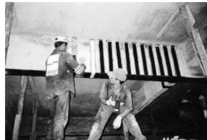
Fotografia 9.6 – Reforço de viga à flexão e ao corte com fibras de carbono.
