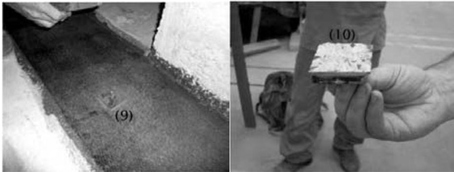
Fotografia 3.12 – Fases construtivas (9) e (10).
