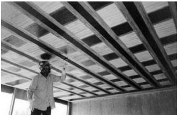
Fotografia 9.12 – Reforço de rasgo em viga para a passagem de dutos de ar. Condicionado. Reforço de laje com laminados de fibras de carbono.
