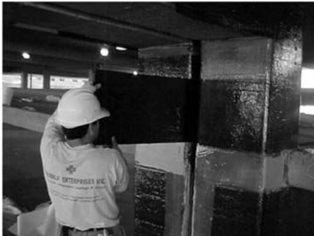
Fotografia 9.7 – Reforço de colunas de juntas ao confinamento com fibras de carbono. Observar que onde passa a mão passa a fibra.
