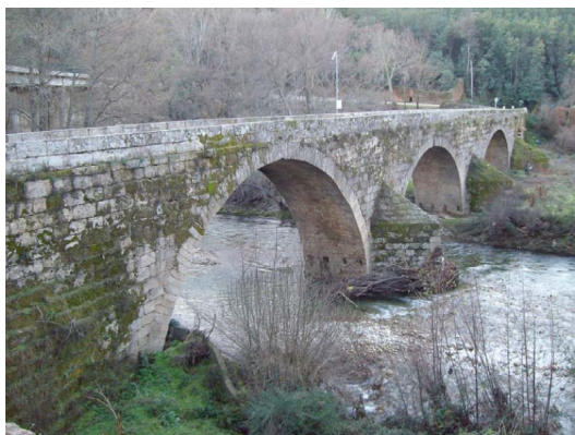
Figura 10 – Ponte com abertura em arco verdadeiro sobre o rio Zêzere, Portugal. (Fonte: https://pontesvida.wordpress.com/tag/alvenaria/ - Acessado em Maio de 2015)
