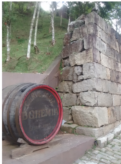
Figura 3 – Seção transversal de uma parede de alvenaria na cervejaria Bohemia, Petrópolis-RJ, maio de 2015.
