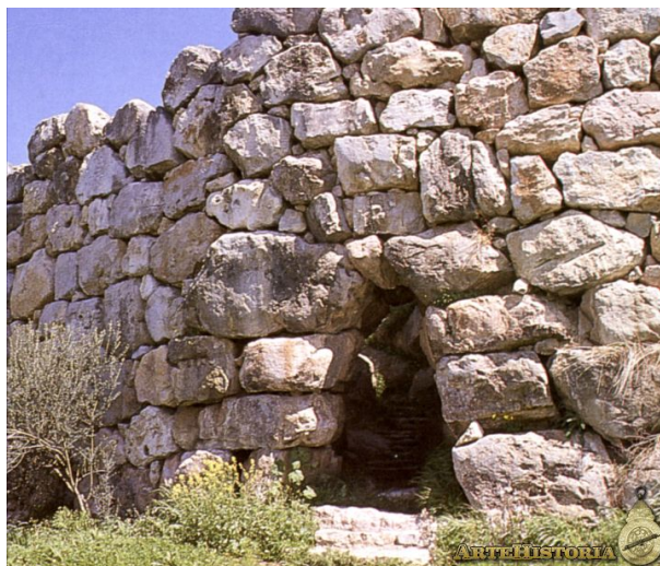
Figura 9 – Arco de fiadas em balanço, Tirinto, Grécia. (Fonte: http://www.artehistoria.com/v2/obras/7833.htm - Acessado em Maio de 2015)
