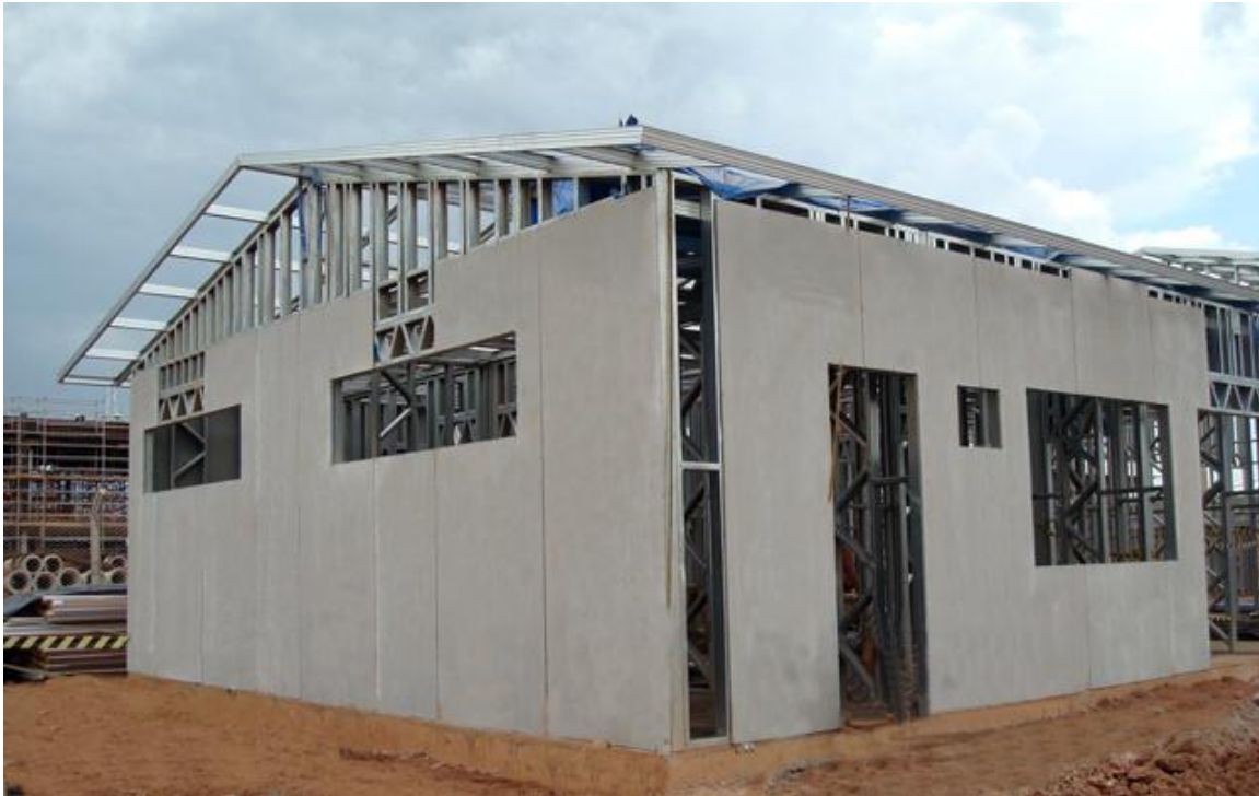
Figura 51: Fechamento com placa cimentícia.
