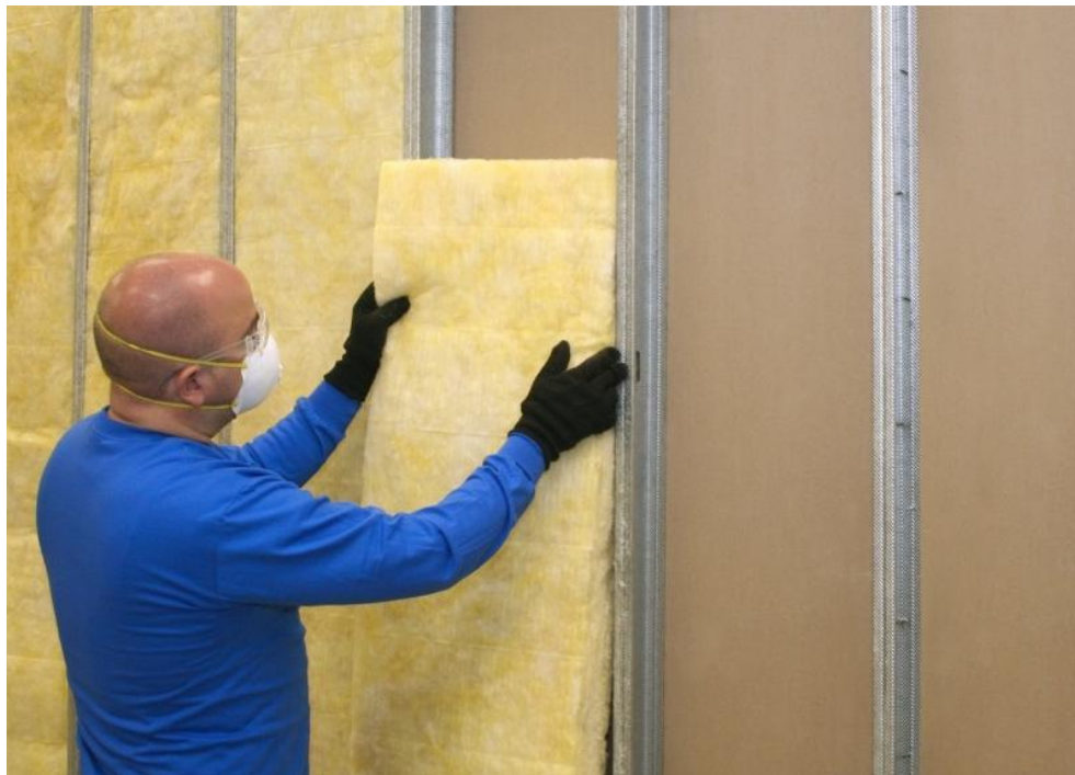
Figura 63: Lã de vidro em forro.
