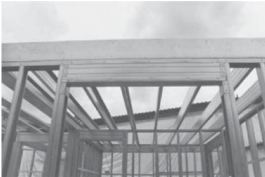
Figura 39: - Vigas de piso apoiadas em montantes de painéis do pavimento térreo.
