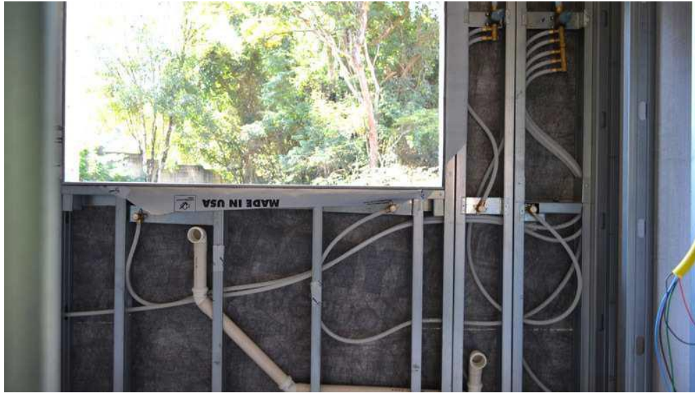
Figura 68: Instalação elétrica / hidráulica no LSF.
