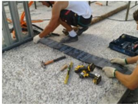
Uso de manta asfáltica em radier no Steel Frame
