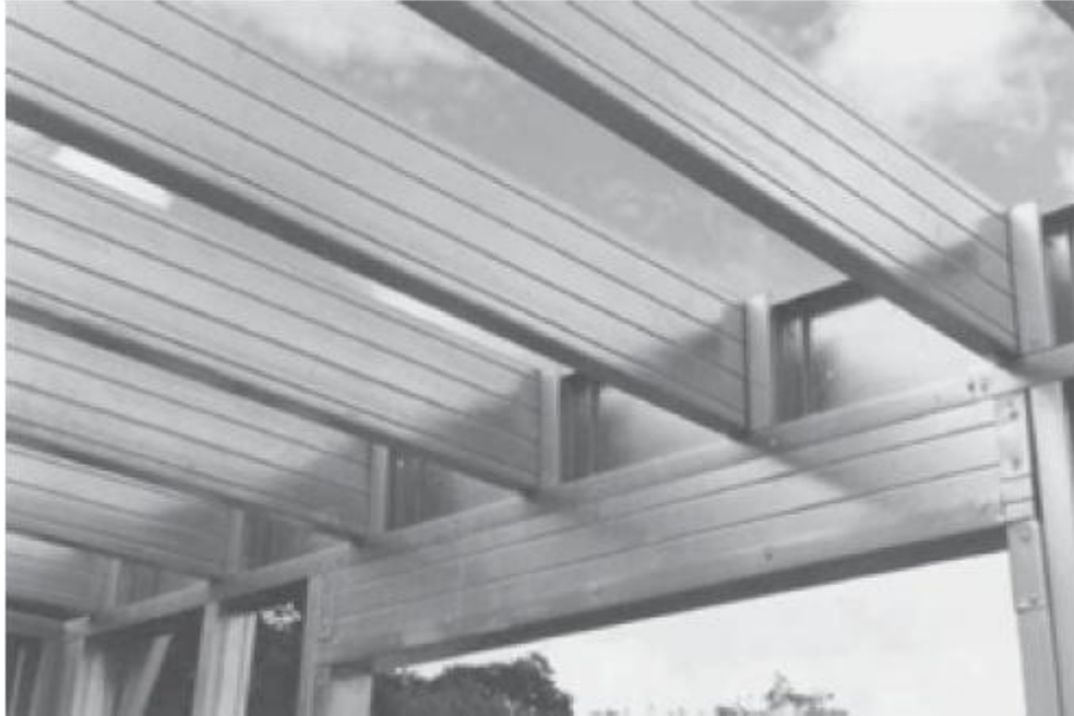
Figura 33: Viga de Piso.
