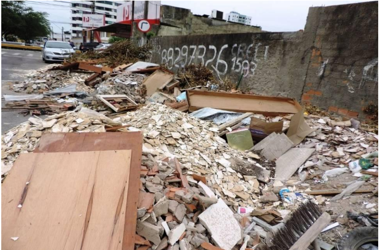
Figura 1: Descarte de resíduos no canteiro de obras.
