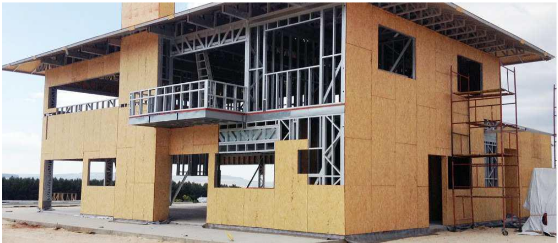
Figura 61: fechamento externo OSB.
