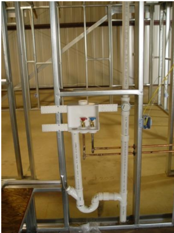
Figura 67: Instalação elétrica / hidráulica no LSF.
