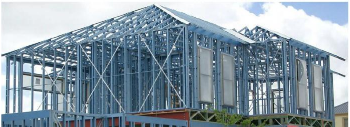
Figura 16: Contraventamento em X.
