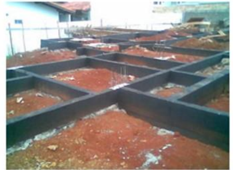
Viga Baldrame – Obra Convencional
