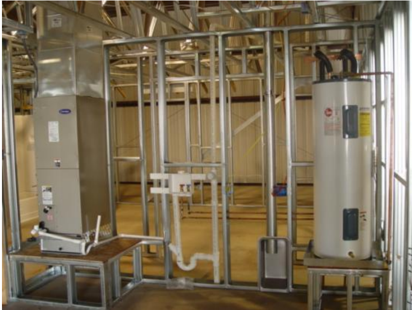
Figura 66: Instalação elétrica / hidráulica no LSF.
